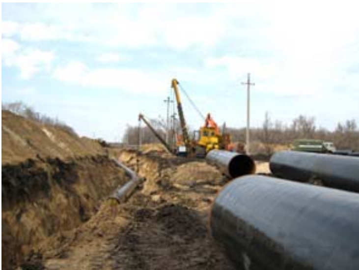
Ремонт трубопроводов: удаление поврежденного участка и вставка нового
