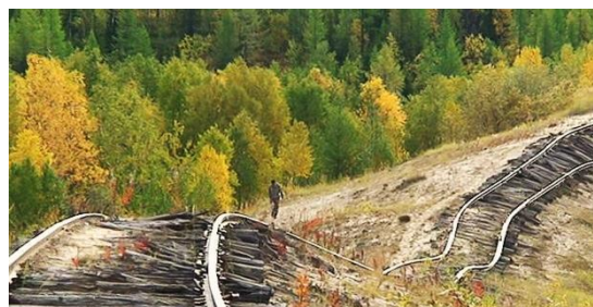
Рис. 3. Результаты проявления мерзлотных (криогенных) процессов
