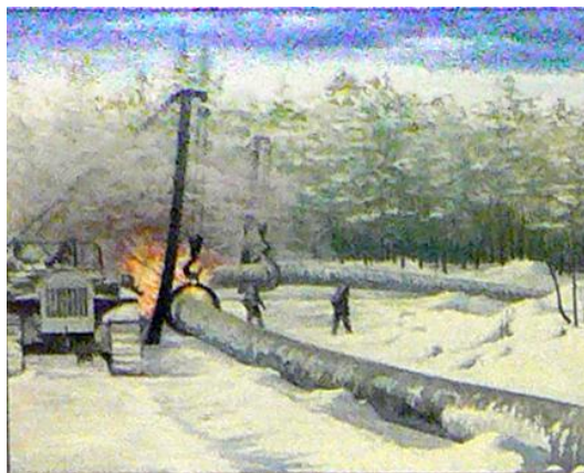
Сварка трубопровода в Западной Сибири (стенд в Музее Землеведения МГУ).
