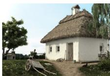
2. Чаще всего стены такого дома сложены из лёгкого и прочного плетня, состоящего из жердей, веток или камыша. Для прочности стены густо обмазаны глиной. Типичным является покрытие стен мелом или извёсткой, отчего они приобретают узнаваемый белый цвет.
